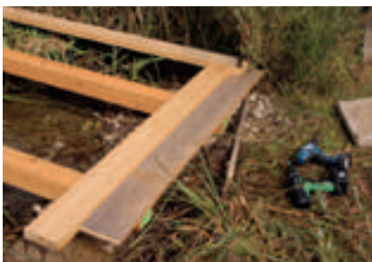
Von wegen Reparatur – der Steg wurde von Grund auf erneuert, Foto: J. Stieda
