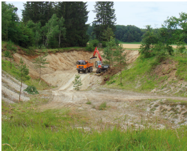
Um der Artenvielfalt wieder mehr Raum zurückzugeben, muss manchmal viel bewegt werden. Foto: V. Oswald
