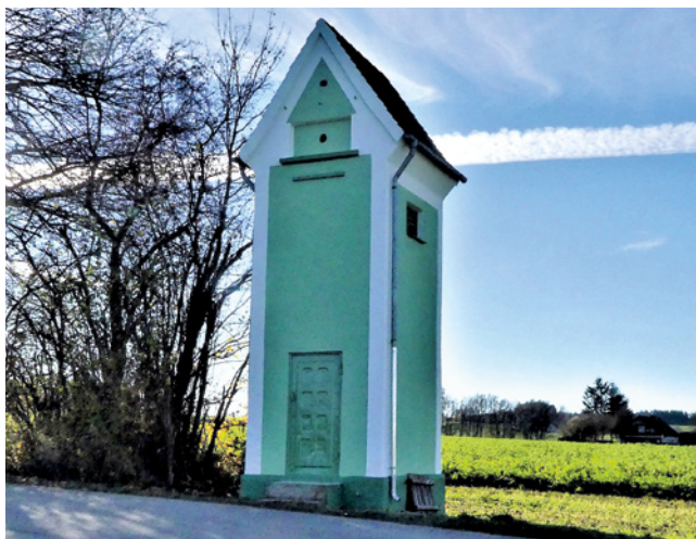
Das Trafohäuschen ist sicherlich das ungewöhnlichste Großnistkasten-Gebäude des LBV. Foto: K. Rössle
